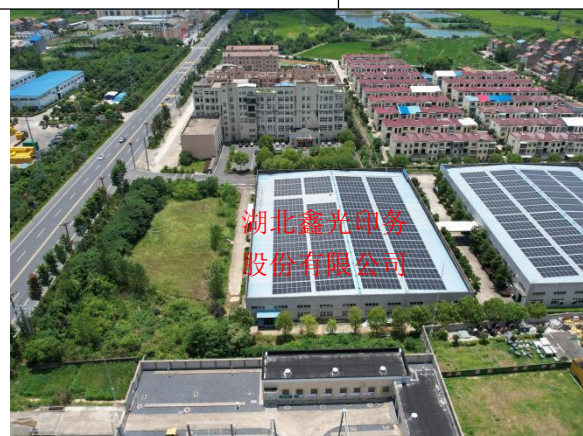
变电站西南侧
