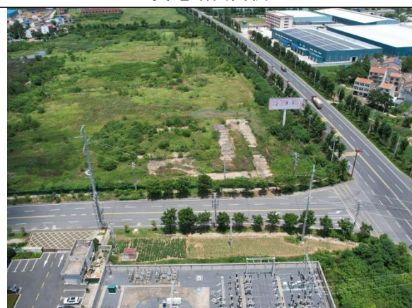
变电站东北侧
