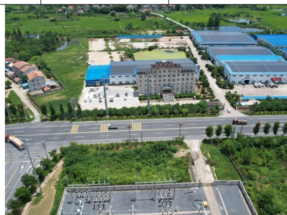
变电站东南侧
