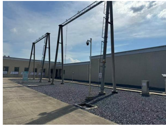
配电综合楼和主控室
