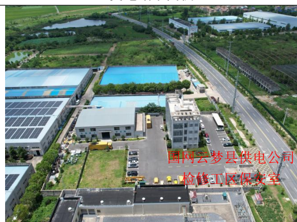
变电站西北侧
