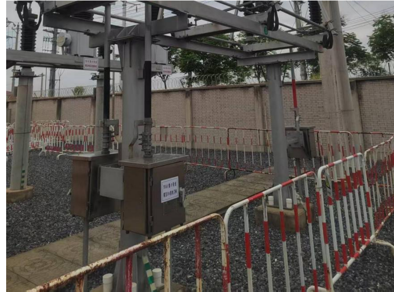
施工场地拦挡
