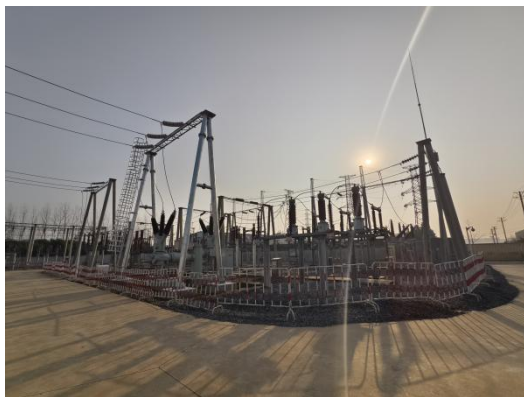
站内 110kV 户外配电装置区
