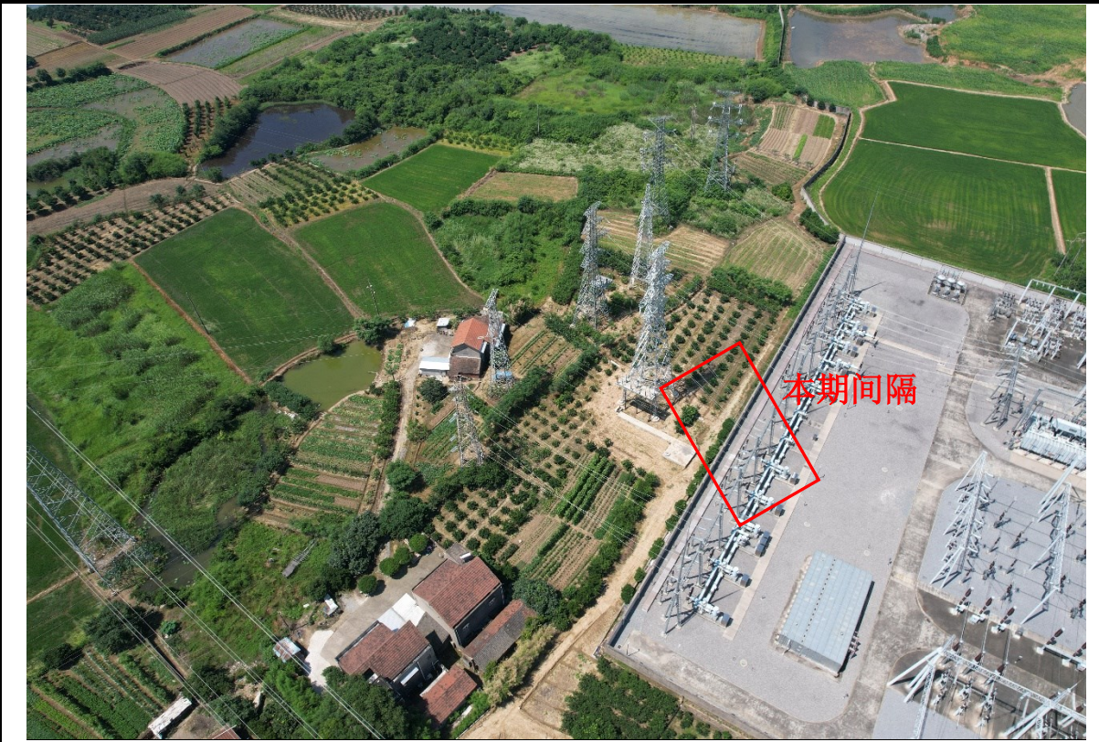
图 4-8 公安变电站 110kV 出线现状照片
