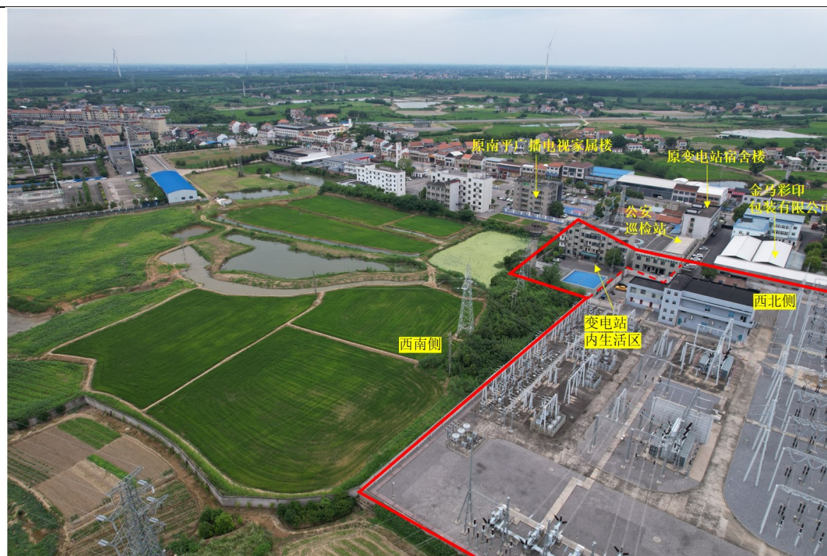
图 2-3 公安 220kV 变电站西北侧保护目标现状照片
