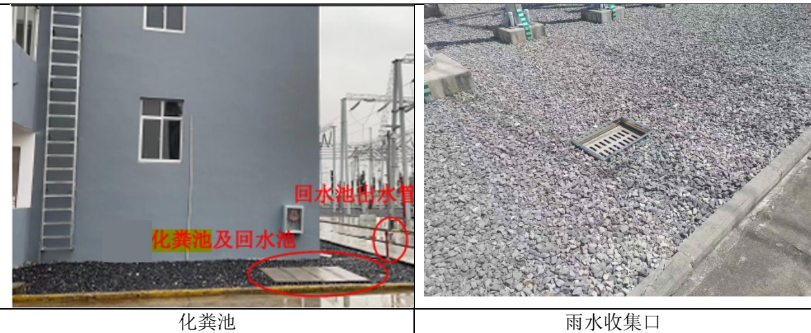
图 4-3 站内化粪池照片
