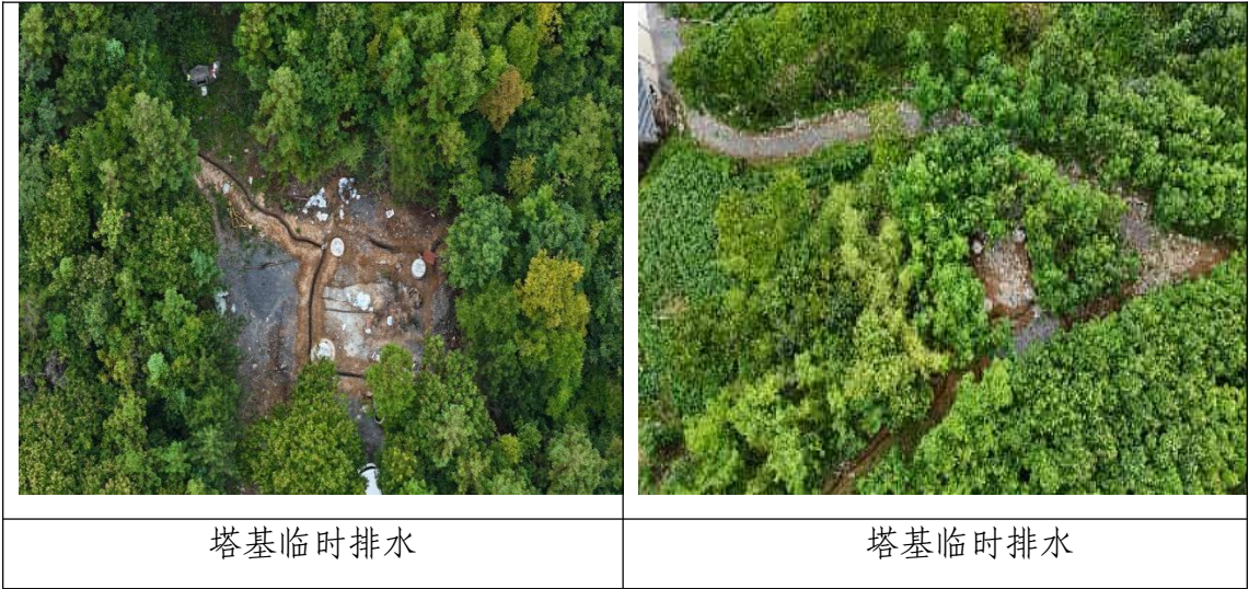
图 3-3 临时措施现场照片
