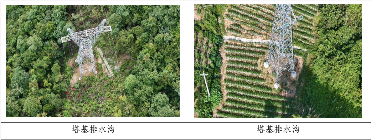
图 3-1 工程措施现场照片
