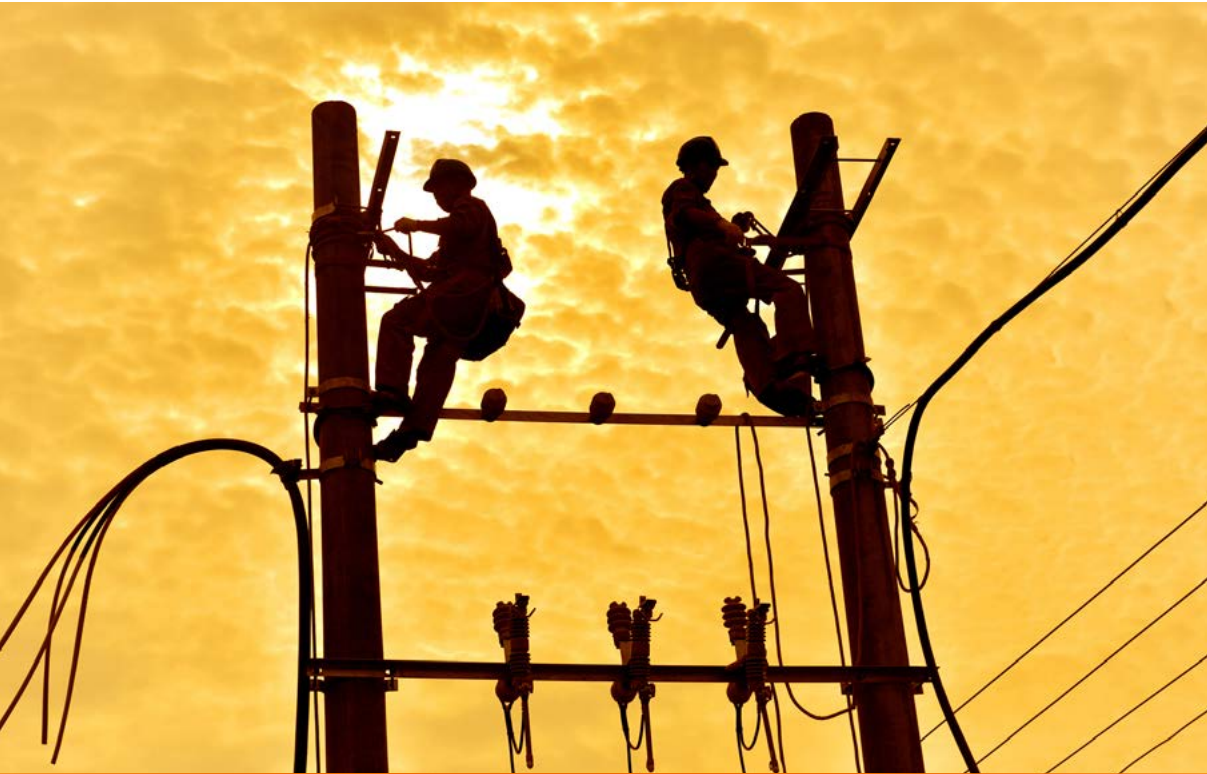
国网襄阳供电公司员工在高温下施工
