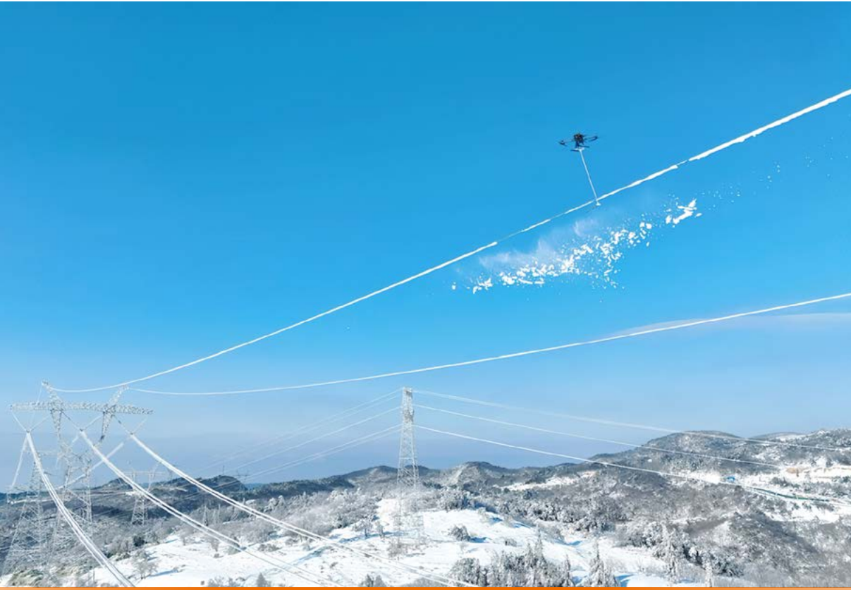
国网湖北超高压公司员工用无人机对三峡电力外送重要通道 500 千伏线路开展除冰作业
