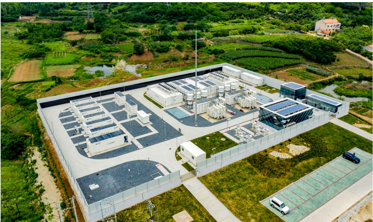
随州广水 100% 新能源新型电力系统科技示范工程
