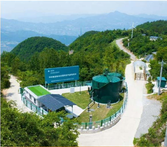
国网恩施供电公司巴东县土店子村沼气发电项目
