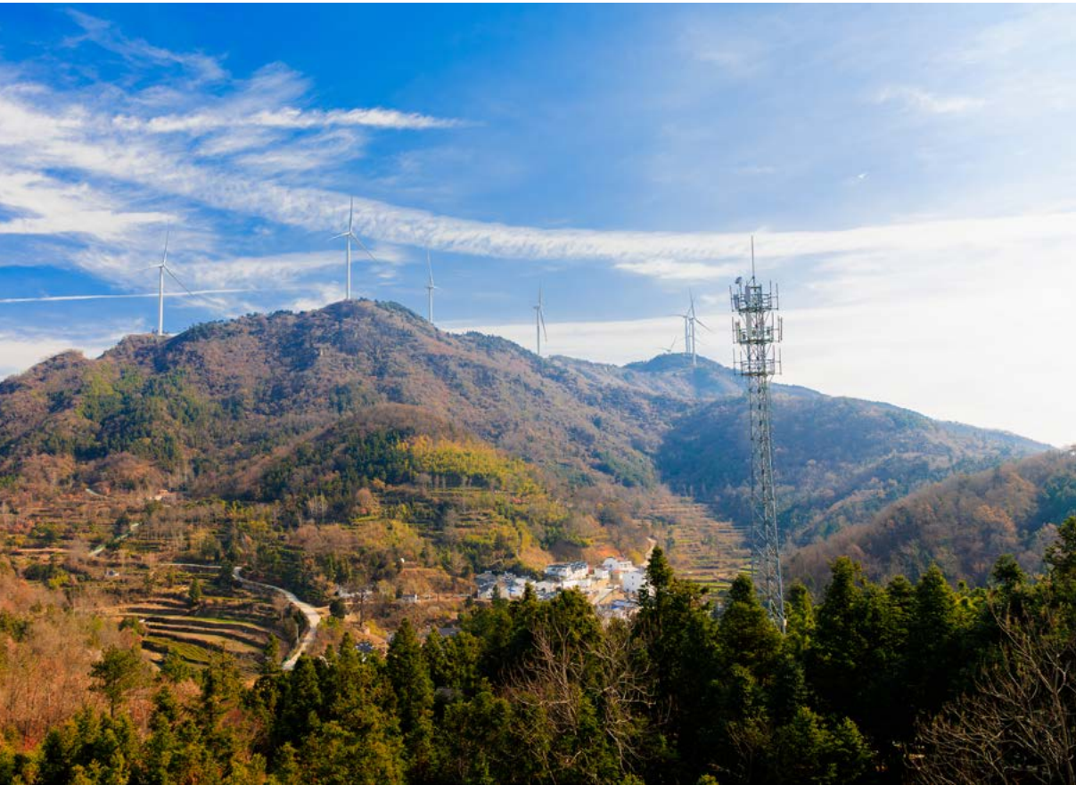
远眺刘家山上的 220 千伏闵冯线
