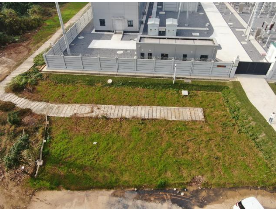
施工生产生活区
