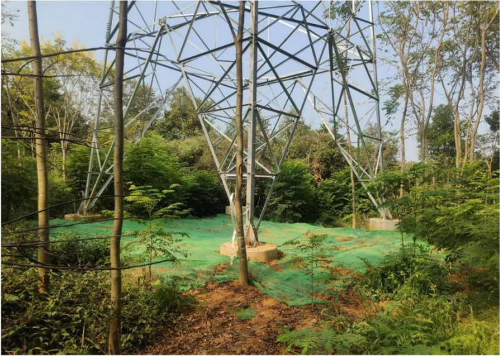
附件 2 施工过程中塔基铺网
