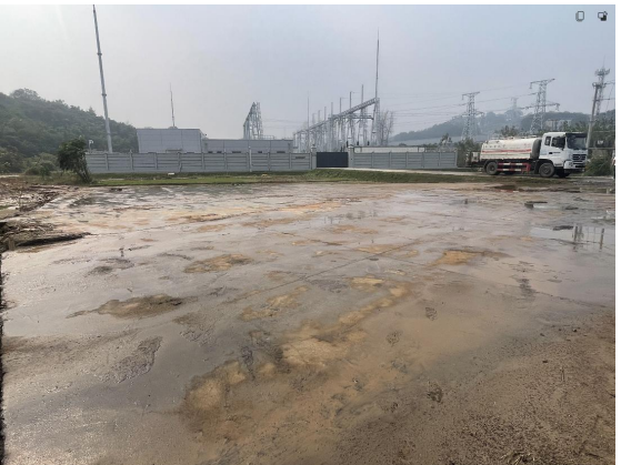
施工生产生活区
