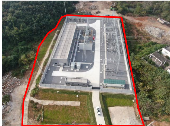
变电站航拍图
