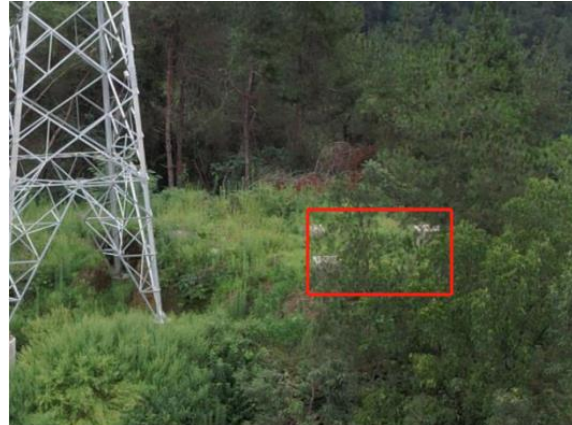
拆除塔基处植被恢复情况
