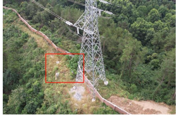
拆除塔基处植被恢复情况
