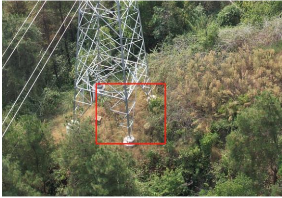
拆除塔基处植被恢复情况
