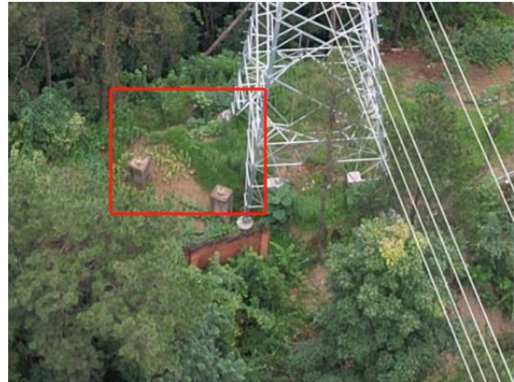
拆除塔基处植被恢复情况
