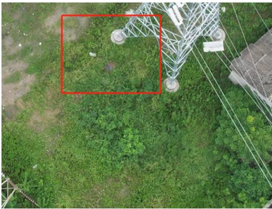
拆除塔基处植被恢复情况
