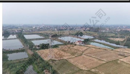
220kV 江里线沿线（砖桥村五组）
