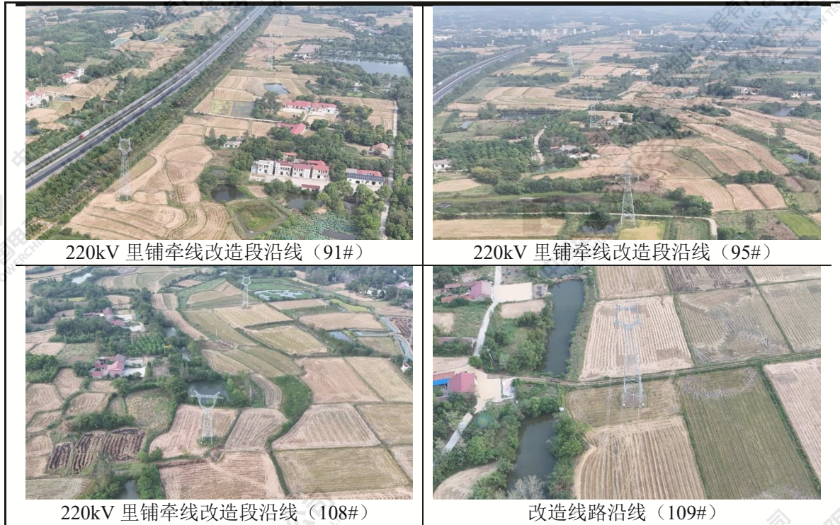
图 4-6 原江陵~五里 220kV 线路 π 入十里铺牵引站线路工程项目现场照片
