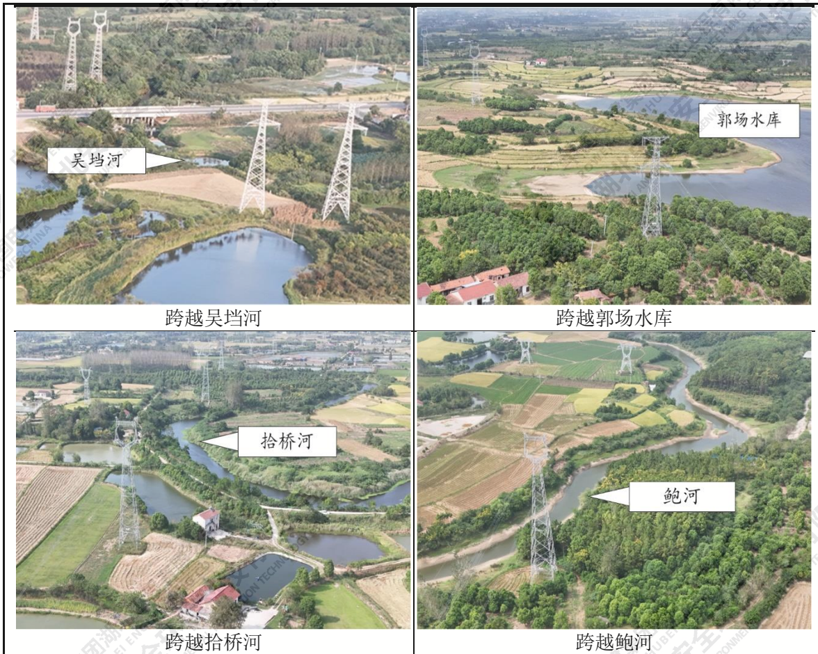
图 8-3 跨越处现场照片
