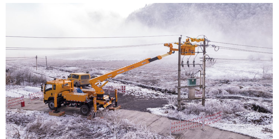
国网恩施供电公司员工 对新增线路实施带电作 业，做好迎峰度冬电力 保障
