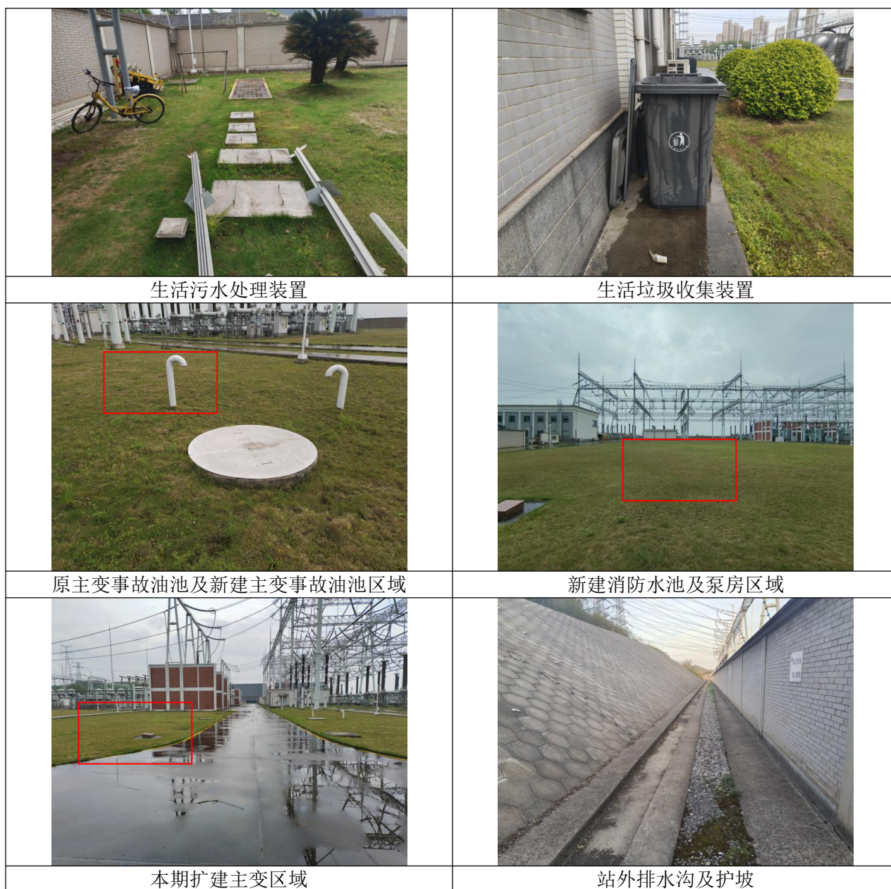
图 3-3 江夏 500kV 变电站实景照片
