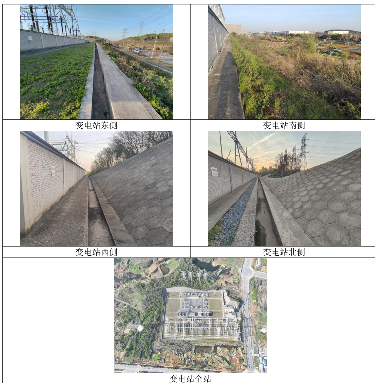
图 4-2 站址四周环境现状照片
