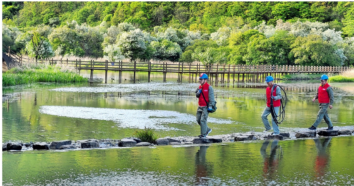
国网神农架供电公司检修人员巡检大九湖风景区线路设备
