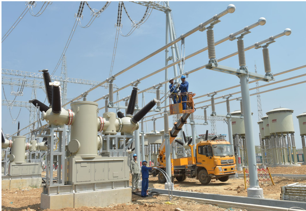
国网湖北送变电公司施工人员在 1000 千伏武汉变电站内安装设备连接线
