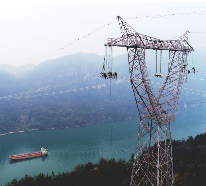
国网湖北送变电公司施工人员对 500 千伏葛双输电线路跨长江段导线更换技改作业
