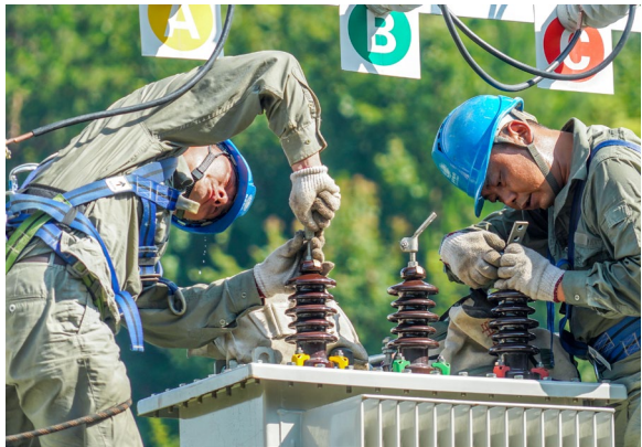
酷暑下国网英山县供电公司员工开展变压器增容施工
