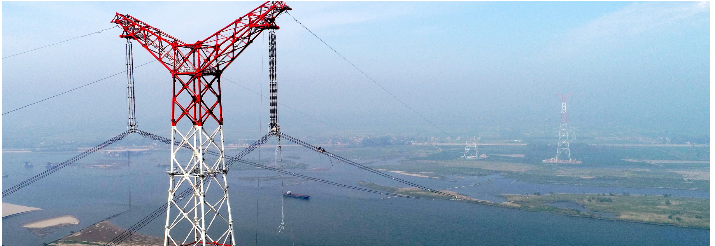
白鹤滩—江苏 ±800 千伏特高压直流输电线路工程跨汉江高塔
