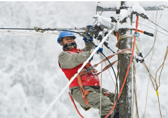
国网荆门供电公司工作人员冒雪登杆作业
