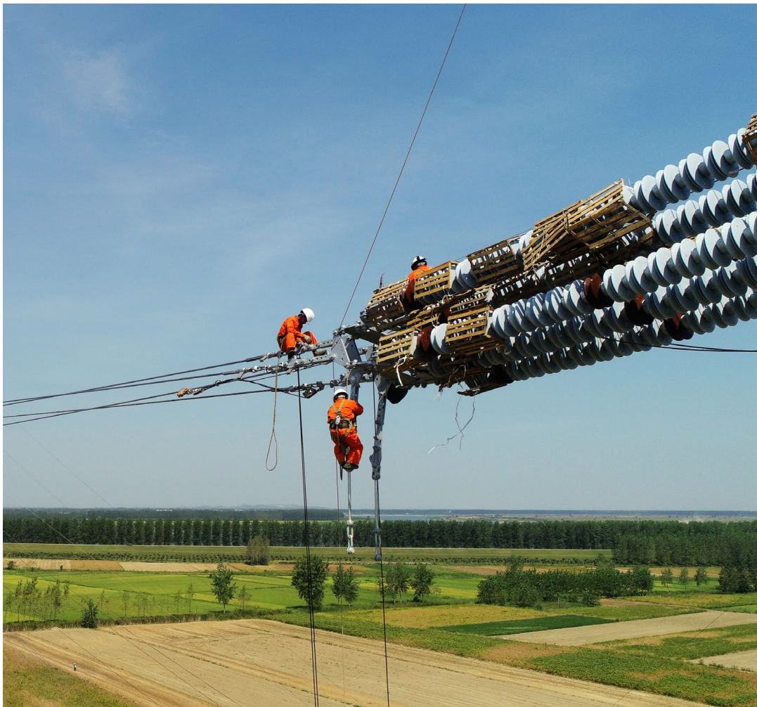
国网湖北送变电公司员工在 1000 千伏荆门－武汉特高压交流输变电工程跨汉江段塔上挂线作业
