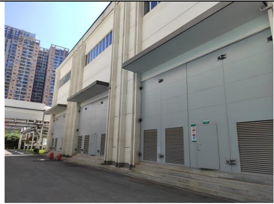
变电站西侧（主变室位置）
