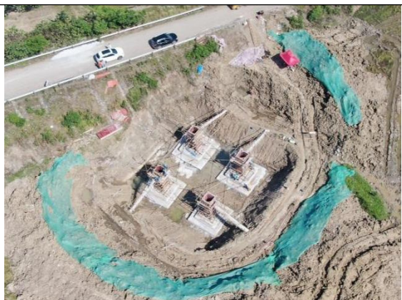
塔基区临时堆土已苫盖
