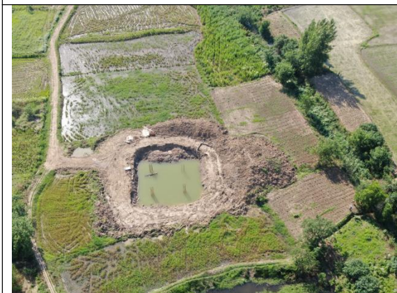
塔基区临时堆土未及时苫盖
