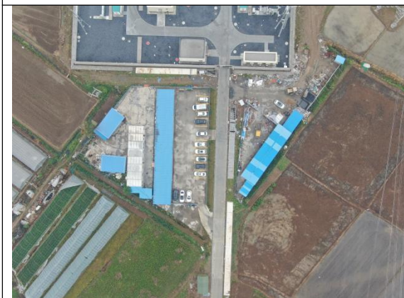
施工生产生活区硬化层未拆除
