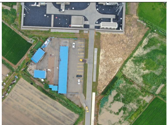
生产区硬化层已拆除，并进行土地整治
