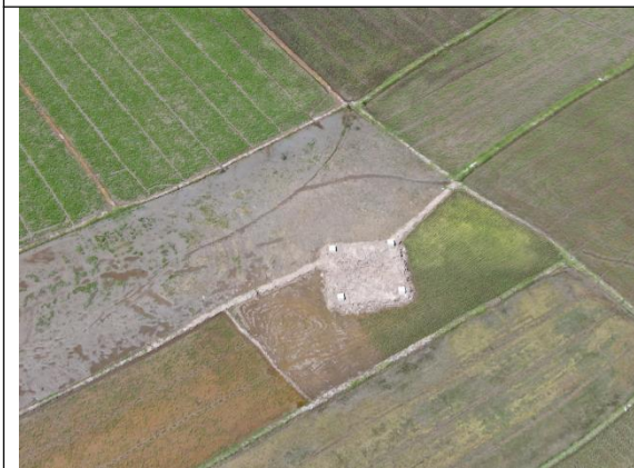
塔基区浇筑完成后，裸露面积较大
