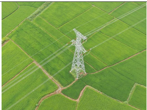
塔基区已复耕
