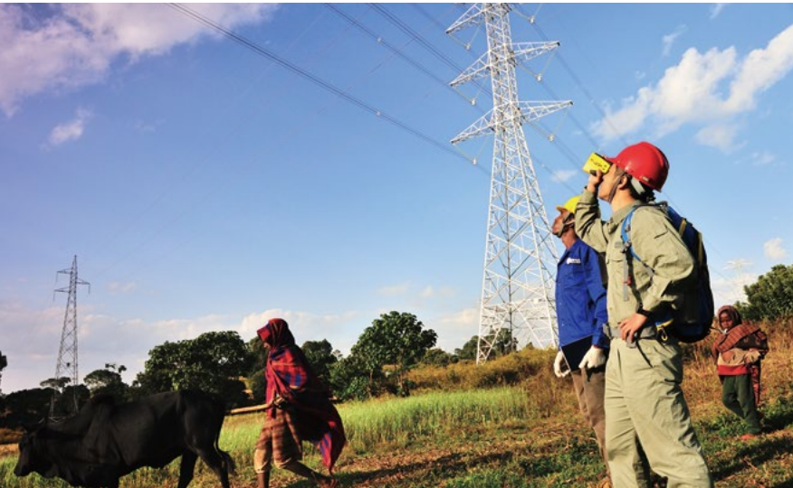
国网湖北检修公司输电运维人员在田野间与埃塞俄比亚人员共同进行线路检视
