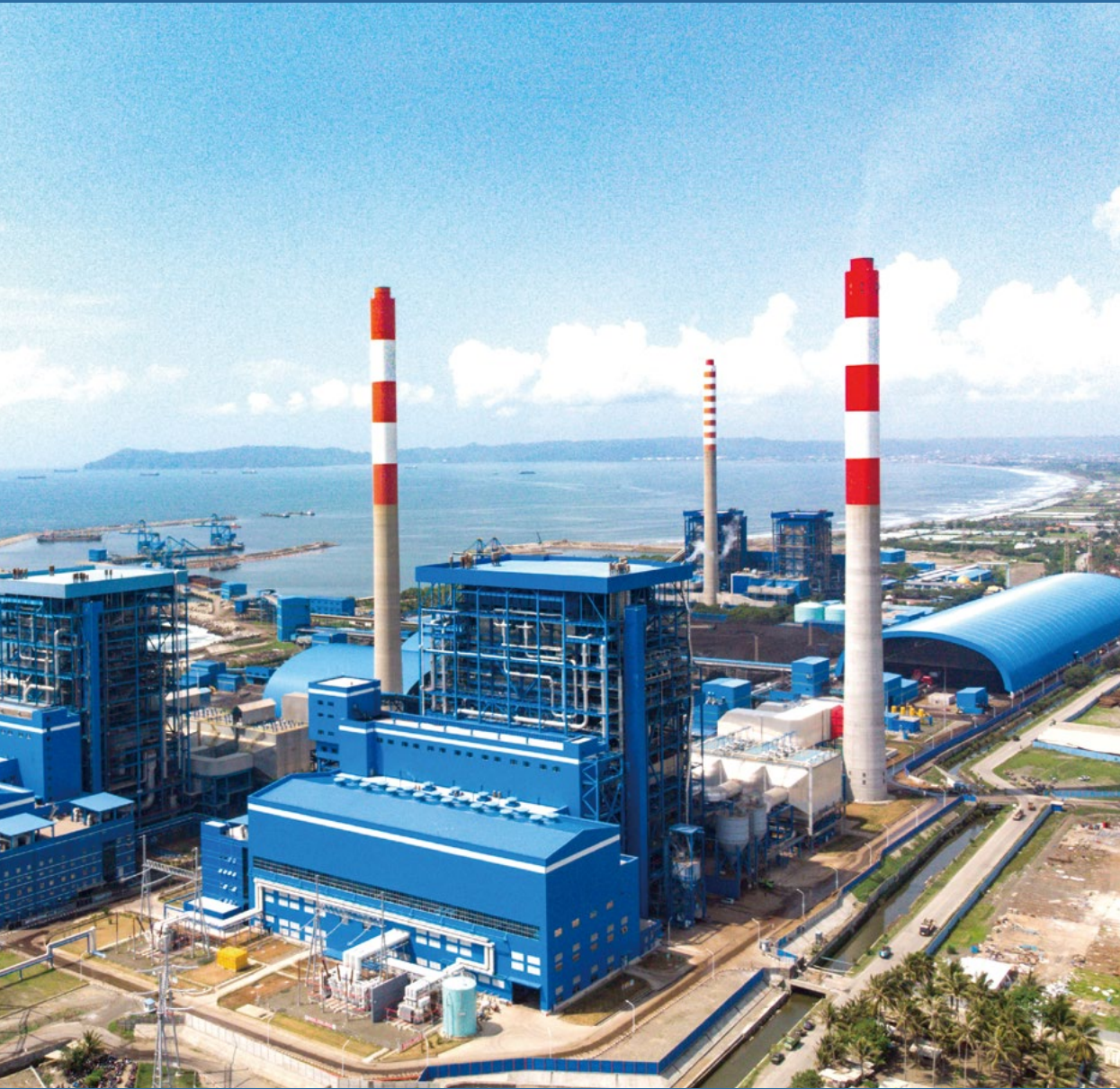
印度尼西亚首台百万机组芝拉扎三期 1000 兆瓦燃煤发电机组
