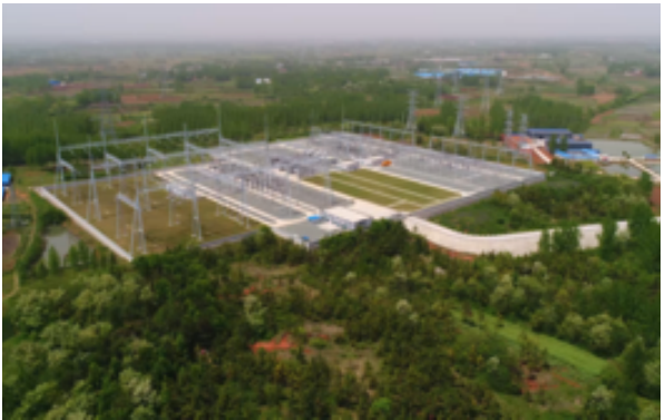
湖北随州 500 千伏变电站工程
