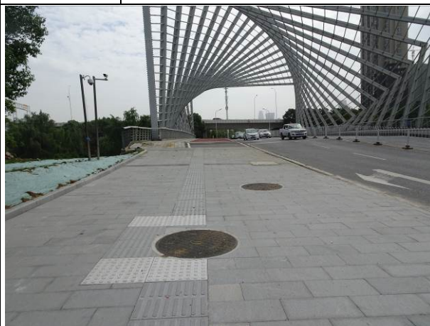
情况说明 穿越烟霞桥顶管施工恢复路面
