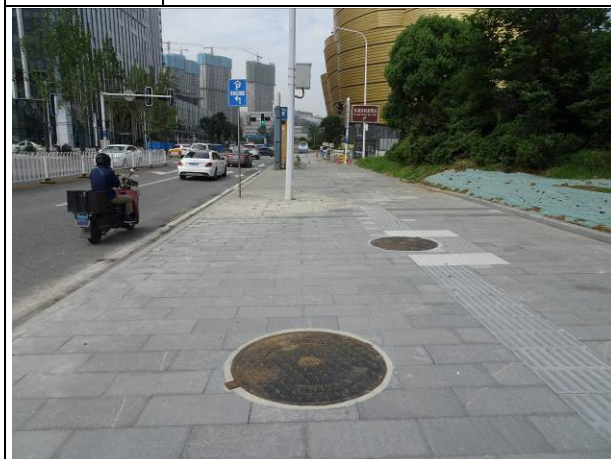
情况说明 顶管井恢复路面
