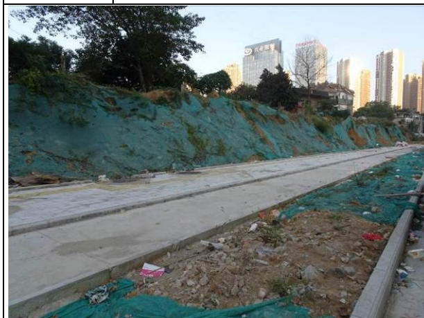
情况说明 电缆沟恢复市政道路（硬化及绿化）
