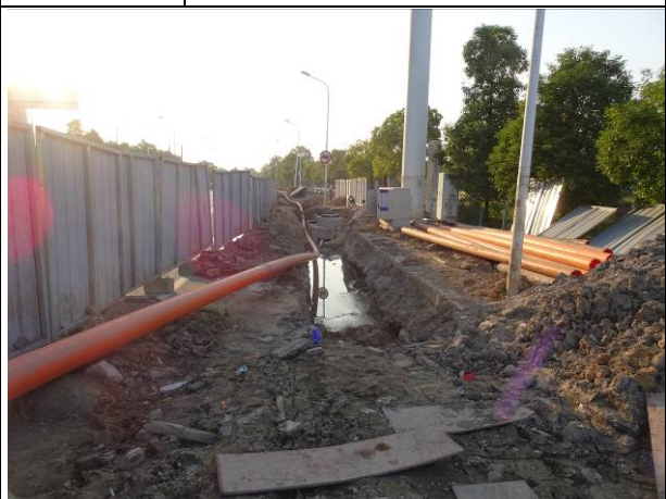
情况说明 烟霞路段电缆沟开挖（围挡板）
