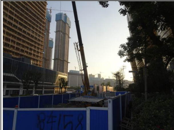
情况说明 顶管施工场地
