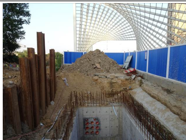
电缆井区围挡板
