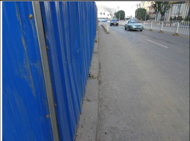
情况说明 顶管施工场地围挡板
