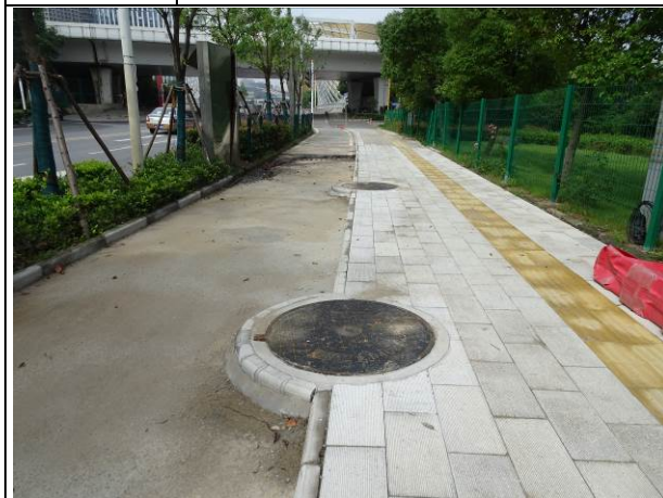
情况说明 烟霞路电缆沟开挖后恢复路面
