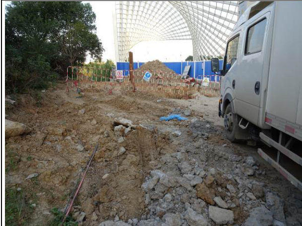
情况说明 顶管施工场地（烟霞桥）
