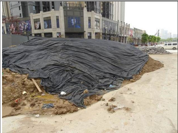
情况说明 临时堆土苫盖
