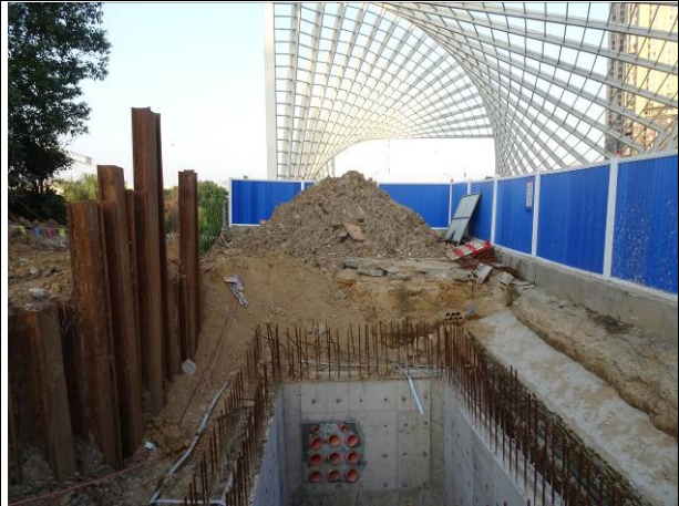
情况说明 顶管工作井及周边围挡板
