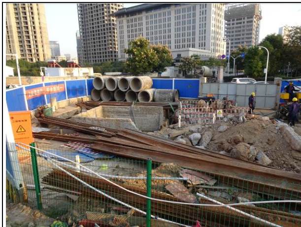
情况说明 顶管施工场地
