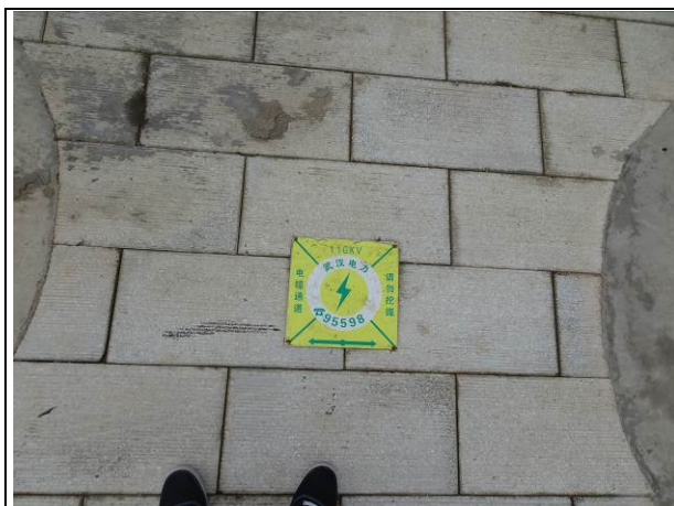
情况说明 电缆沟硬化路面
