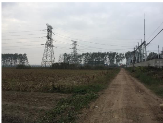
变电站西南侧外环境
