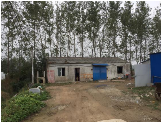
庙头村王元海家 (变电站东南侧)
