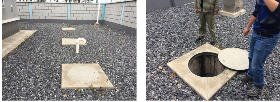
图8-2 站内已有化粪池
