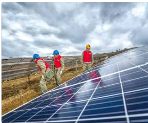
“三县一区”村级光伏电站
