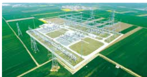
俯瞰卧龙变电站
