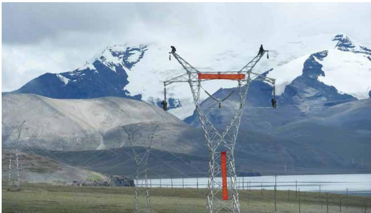
送变电工程施工人员正在海拔5200多米高的西藏自治区山南市浪卡子县打隆镇境内进行放线作业
