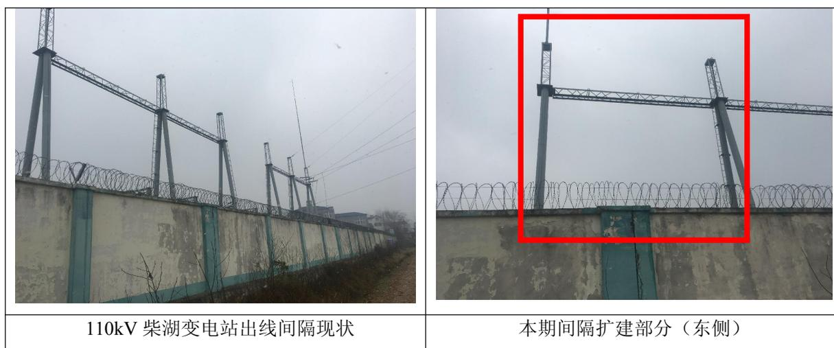
图1-2 110kV 柴湖变电站110kV 间隔扩建情况示意图
