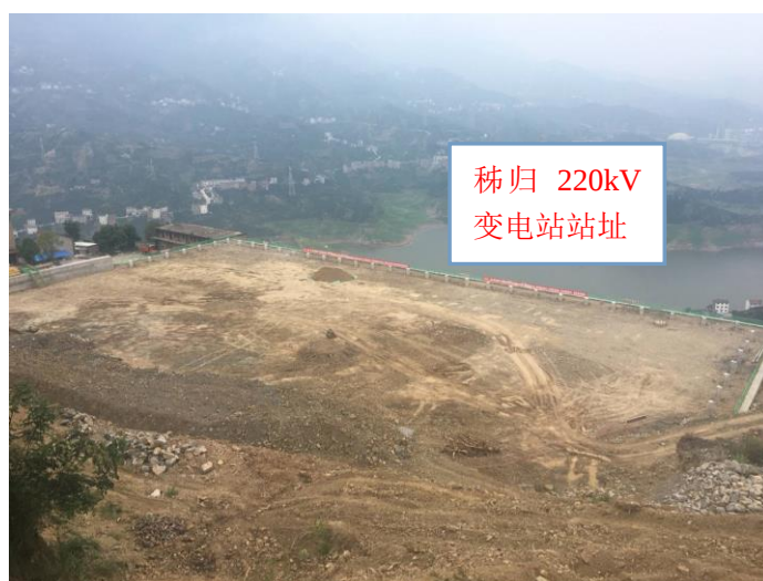
图 2 秭归 220kV 变电站站址所在位置以及建设情况
