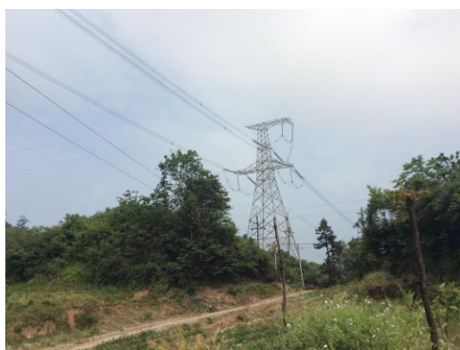
图 3 本工程 220kV 线路钻越 500kV 盘龙 I、II 回线路
