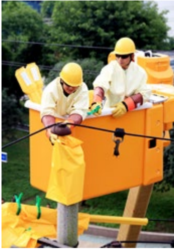
开展配网带电作业
