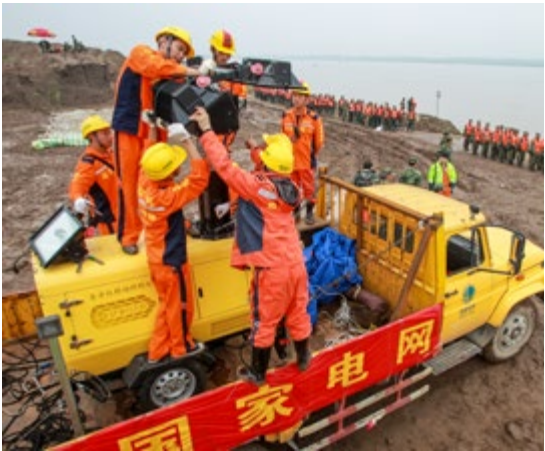
现场搭设移动灯塔，开展抢险保电
