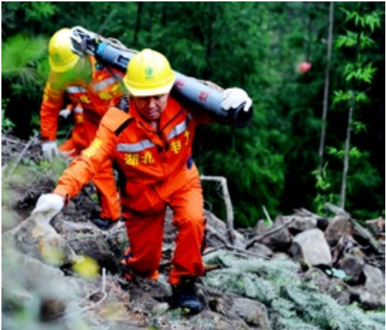
雅安芦山抗震救灾，打通生命通道
