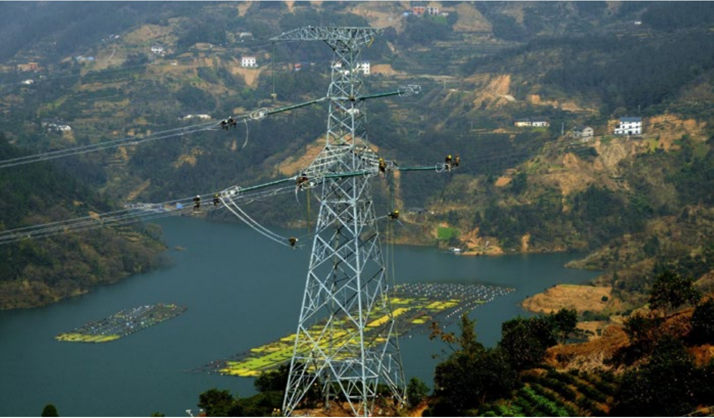
三峡地下电站外送工程
