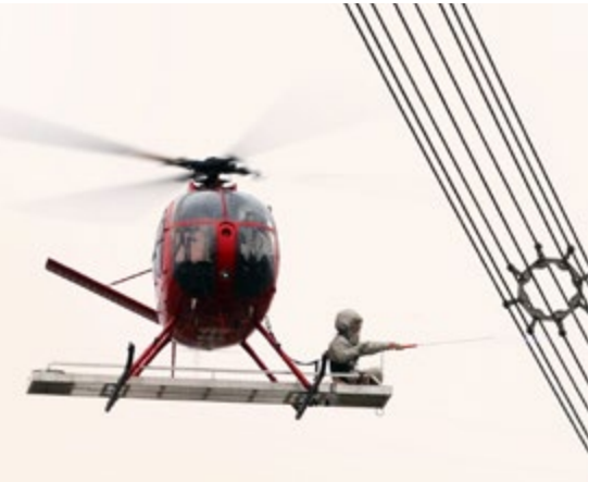
带电作业员成功进入等电位作业，完成世界首次 1000 千伏特高压直升机带电作业
